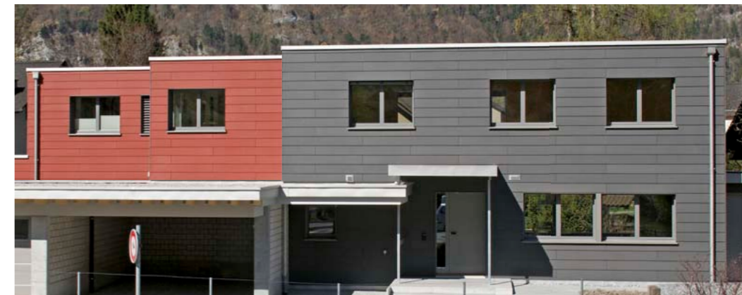
Eternitfassade an zwei Häusern in Mollis.
