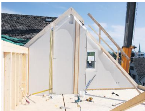
Dachausbau mit vorgefertigten Holzelementen
