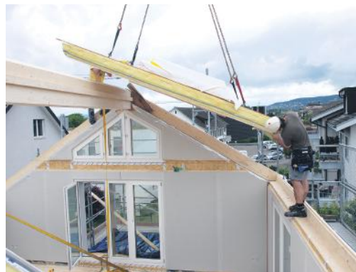
Dachausbau mit vorgefertigten Holzelementen
