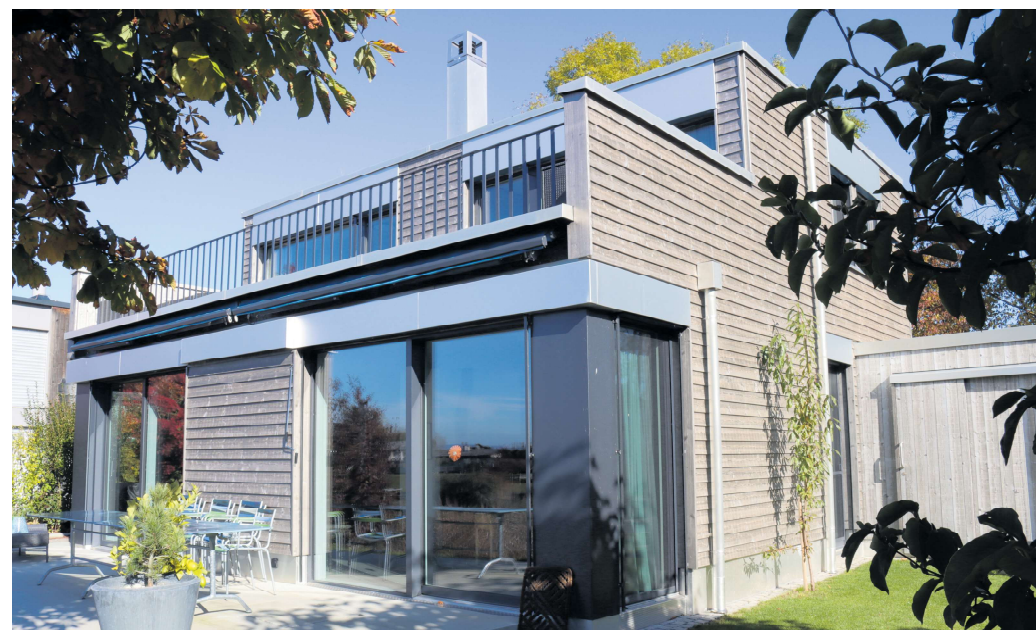
Holzbau: Casa-Vita, Mollis / Architektur: Saratz Architektur, Zürich
