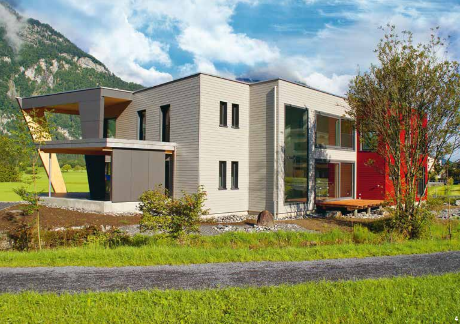
4 Die Terrasse auf der strassenabgewandten Seite dient als zentraler Treffpunkt für die Benutzer und Kunden.
