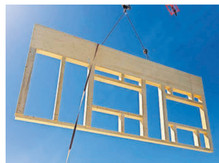
Ein vorgefertigtes Element wird per Helikopter auf die Baustelle transportiert.
