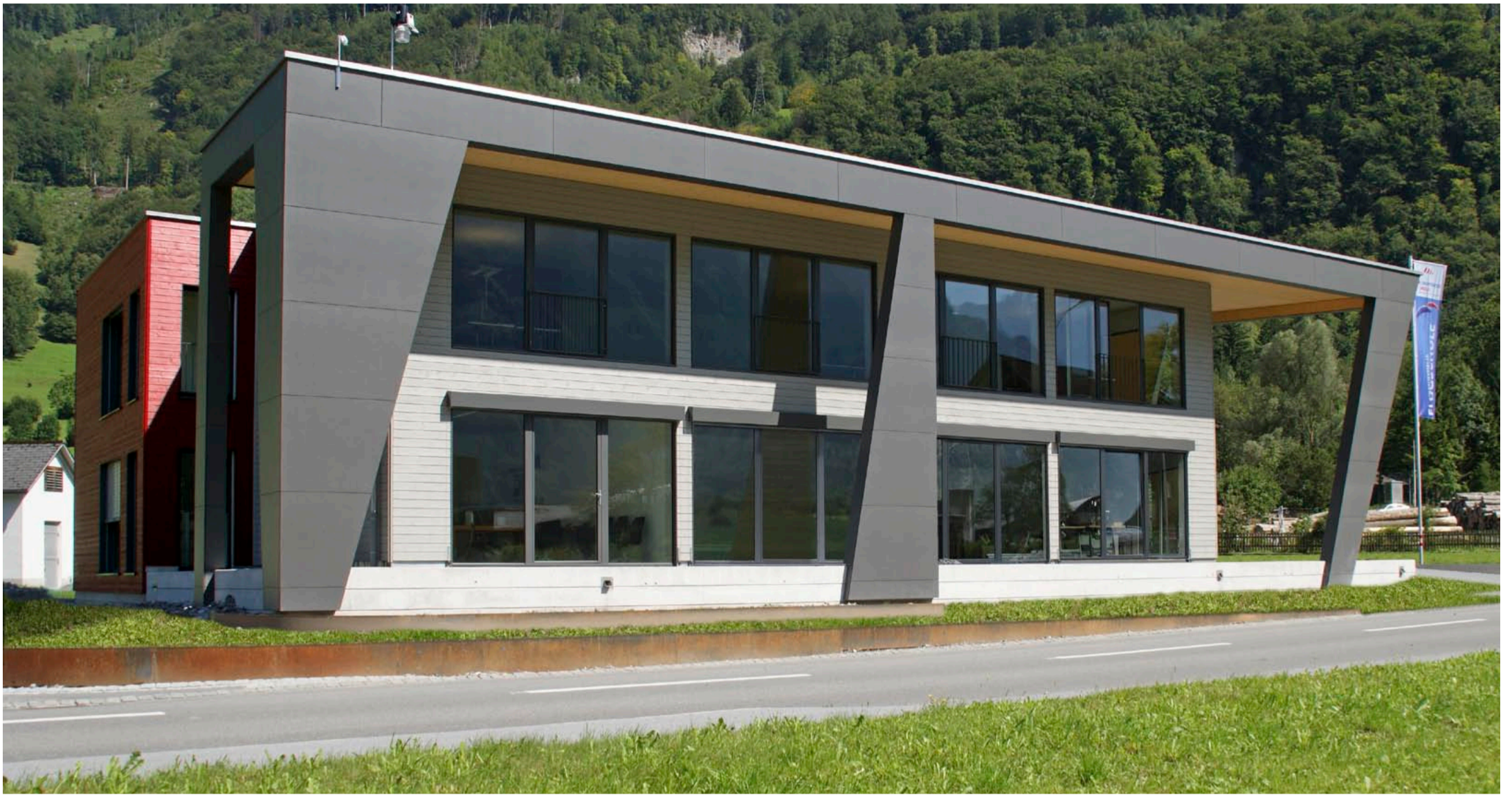
Das «Haus am Sagibach»: Ein eigenwilliger Kubus an dominantem Standort am südlichen Dorfeingang von Mollis.
