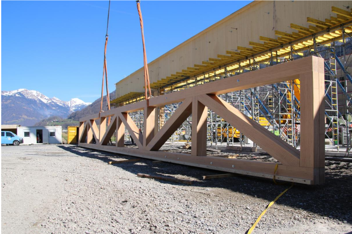
Das Abfangfachwerk wird für den Spezialkran bereit gemacht.
