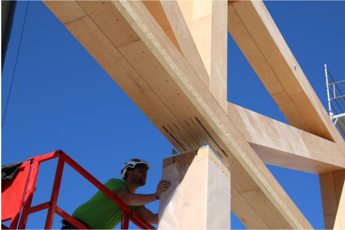
Präzisionsarbeit mit mehreren Tonnen Holz.
