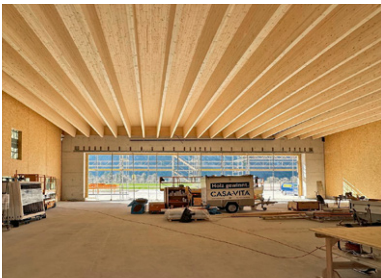
Oben: Für die Basis Mollis wurden 213 vorgefertigte Holzelemente verbaut. Unten: Der Hangar der neuen Basis.
